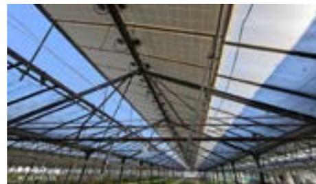
↑ Les panneaux sont installés sur les ouvrants de la toiture, et sont orientés est-ouest. Leur ouverture en bascule permet aux panneaux de s'orienter en fonction du mouvement du soleil dans la journée © FRAB AuRA
